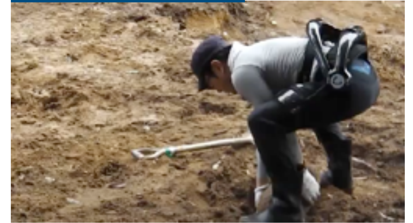
土砂の除去作業
