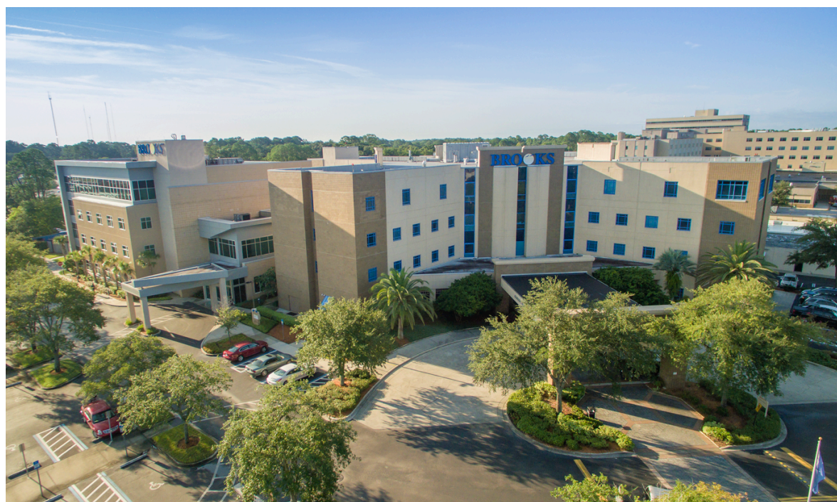
Brooks Rehabilitation 施設外観
