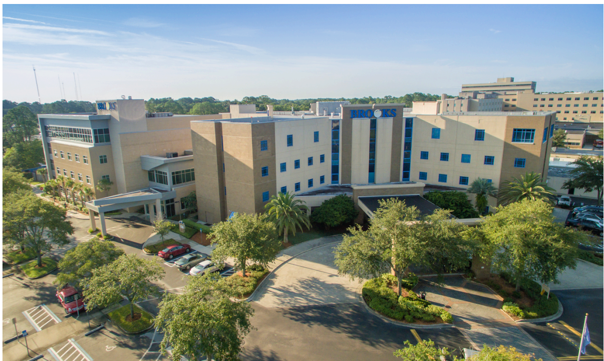
Brooks Rehabilitation 施設外観
