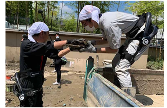
熊本県人吉市での災害復旧活動（2020年7月）
