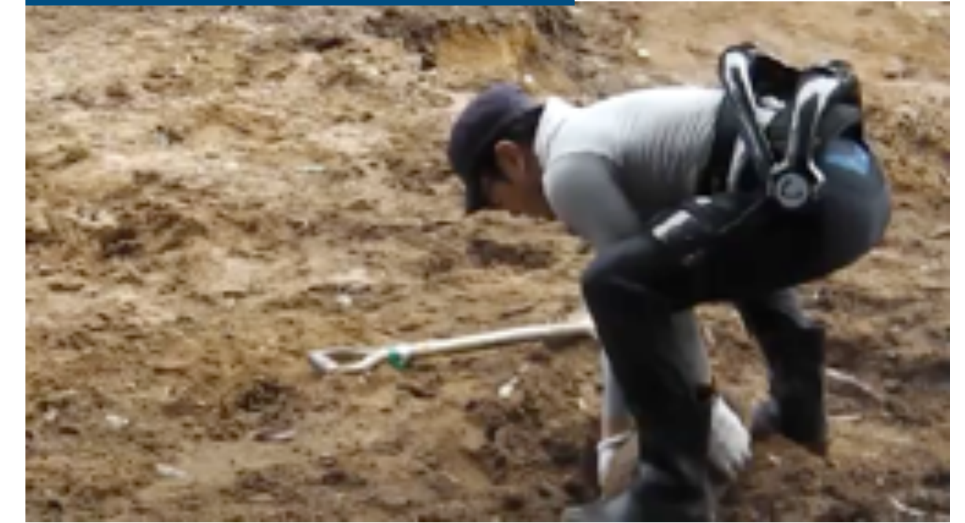
土砂の除去作業
