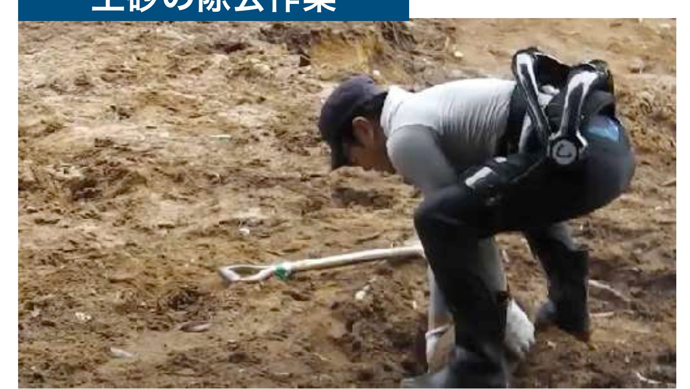
土砂の除去作業
